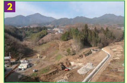
土曾川大橋北側の状況
