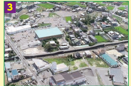
リニア駅予定地付近の状況
